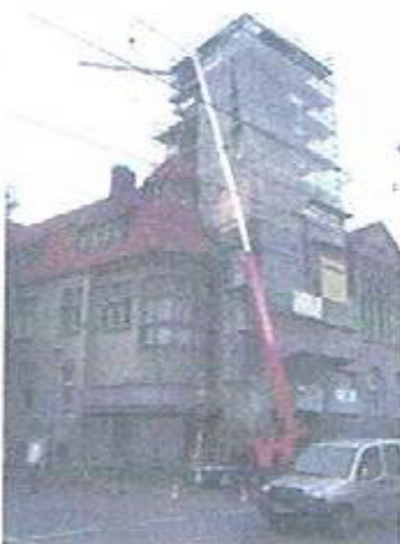
Bei fließendem Verkehr werden die bis zu 5,50 Meter langen Metallträger mit einem Spezialkran in Balkenhöhe des Turmes gehievt.
